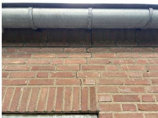
gevel no. 9: zetscheur (2025)
