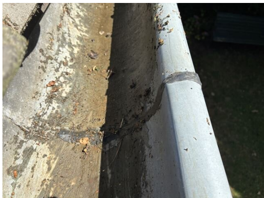
goot no. 8: soldeernaad tijdelijk hersteld met lijmkit (2025)
