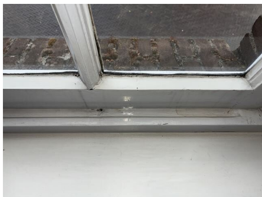
eerste verdieping: kitranden verouderd (2025)
