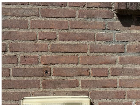
gevel no. 3: oude keilbout (2025)
